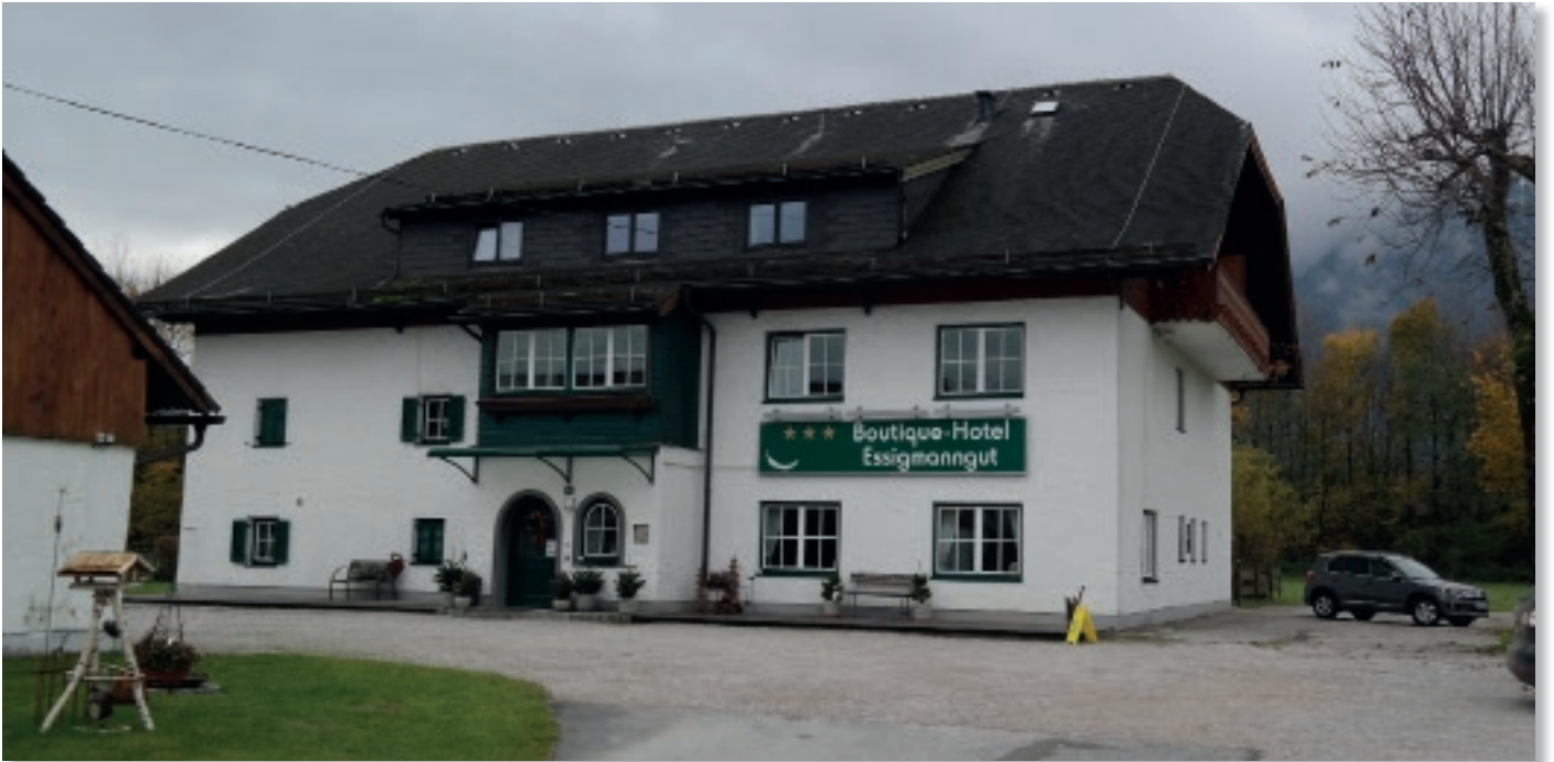
vor der Renovierung
